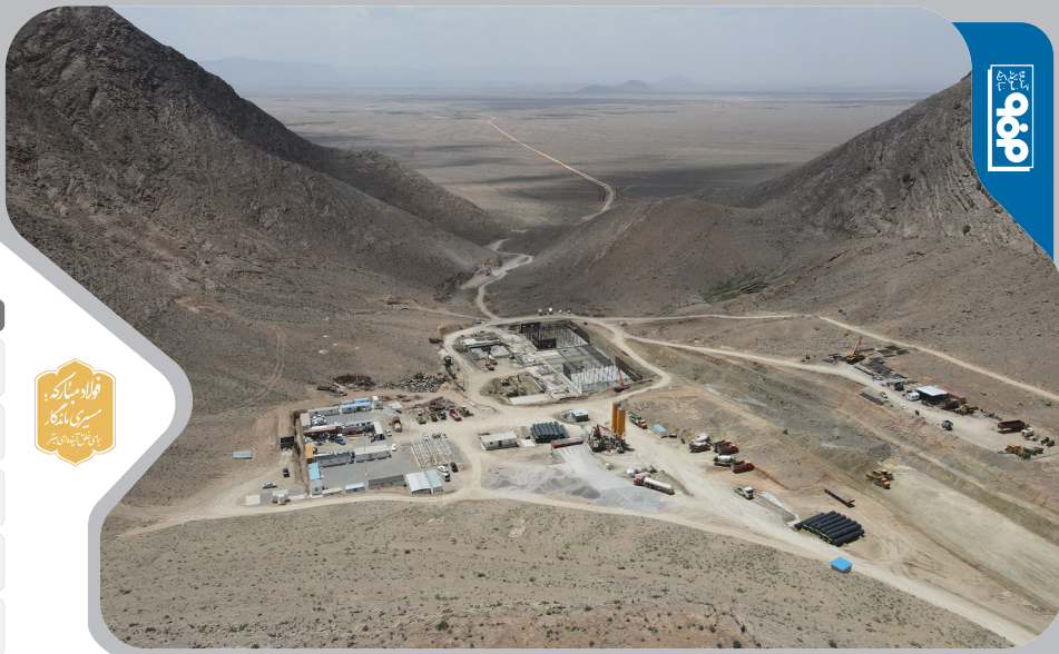
مخزن تعادلی انتقال آب - ابرپروژه انتقال آب دریا به صنایع بزرگ اصفهان
